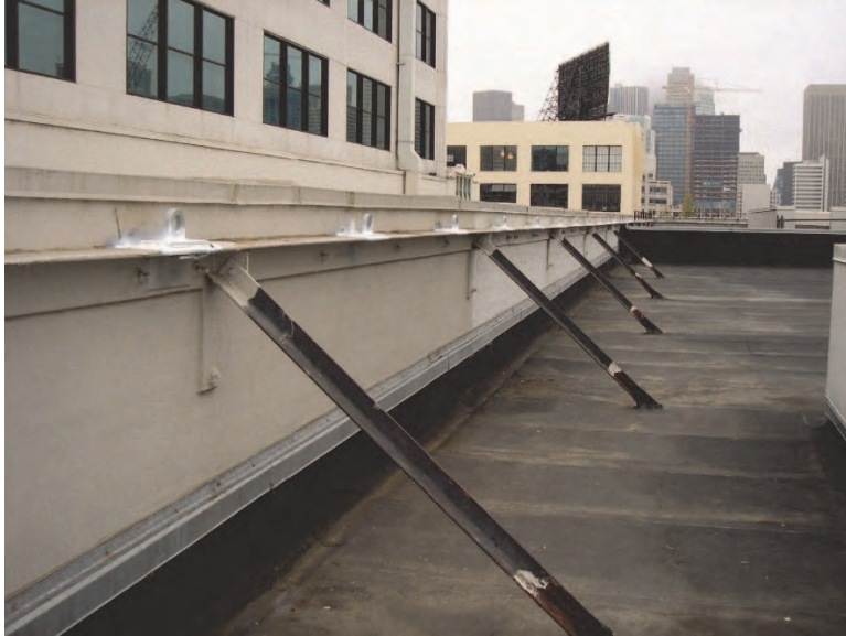
Նկար 6-4 Քիվապատի ամրակապման օրինակ (FEMA, 2012).
