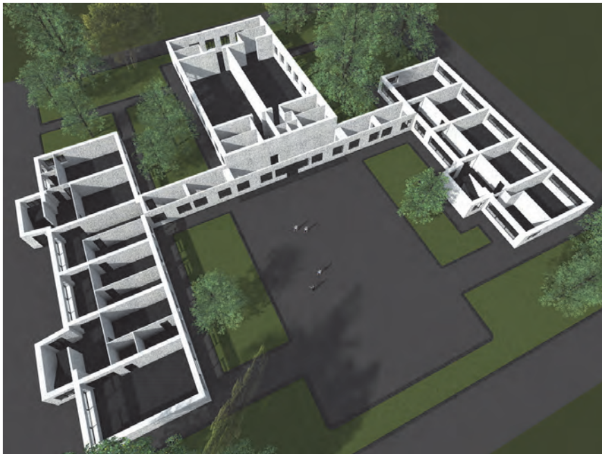
Նկար 2-3 Միջանցքային համակարգերով միմյանց կապված և հակասեյսմիկ կարաններով բաժանված բազմակի անկախ հատվածամասերից կազմված տիպային դպրոցական շենքային համալիրի տեսք (EEC et al., 2015)
