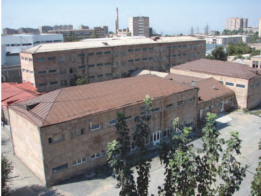
Նկար 2-2 Կրող պողպատե տանիքային կոնստրուկցիաներով ծածկած D-1 և D-2 տիպերի շենքերով դպրոցական տարածք Երևան քաղաքում
